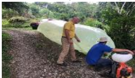
Construcción de biodigestores en Abangares
