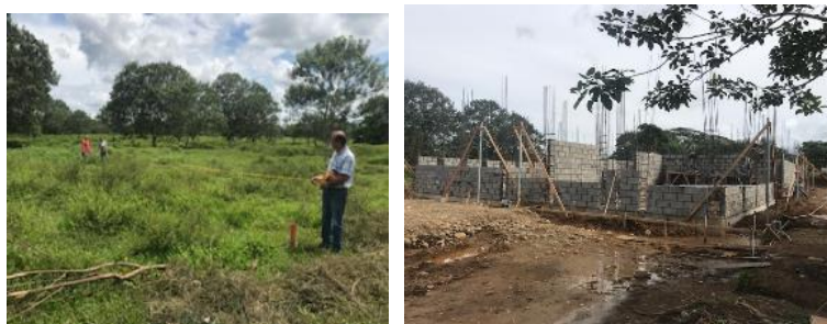
Primeras obras para la construcción y planta en construcción.
