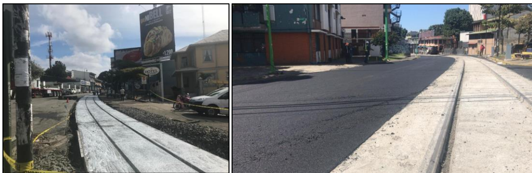
Figura 1. Paso a nivel reconstruido Avenida Segunda
