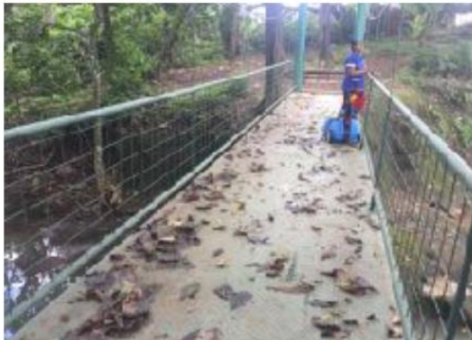
Puente metálico en cauce Río
