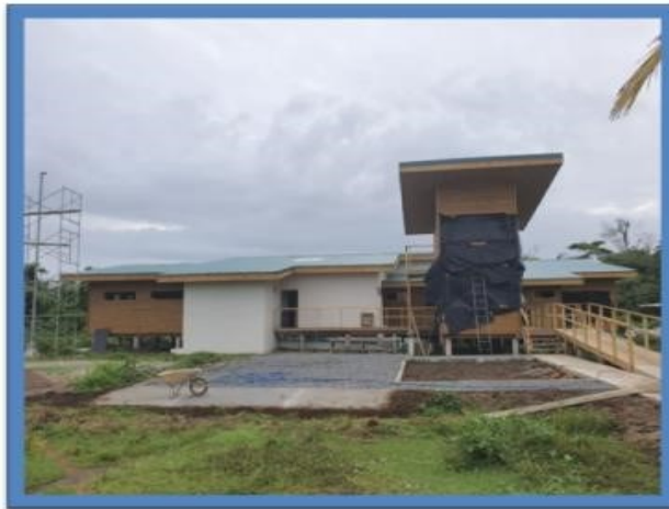
Construcción Unidad Móvil Policía de Fronteras Agua Dulce Ejecución (Avance de 80%)
