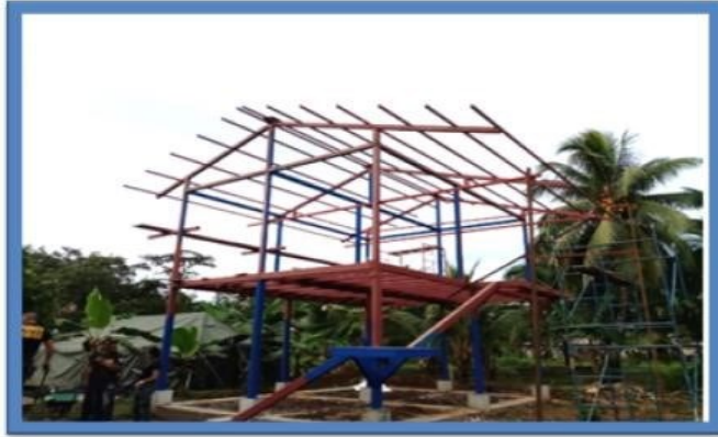
Construcción Puesto Policial Fronteriza Boca de Sarapiquí Ejecución (Avance de 65%)
