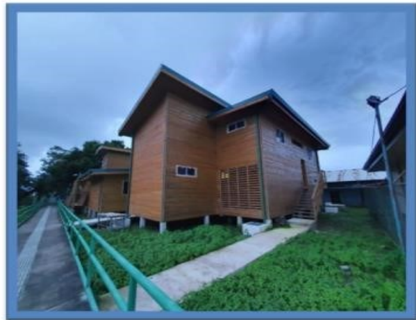
Construcción Policía de Fronteras Barra Colorado Sur Ejecución (Avance de 90%)
