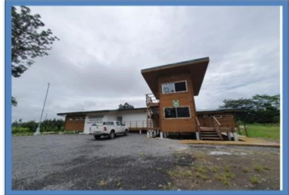
Construcción Policía de Fronteras Delta Costa Rica Recepción Provisional (Avance de 99%)
